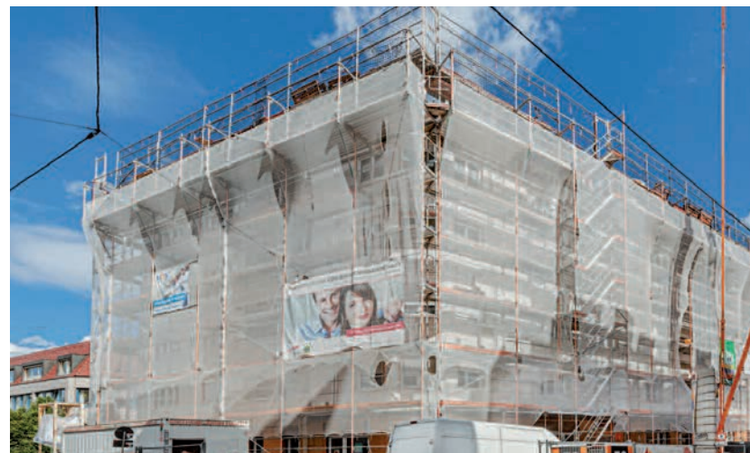
Modernisierung Stuttgart Urban-/ Hallbergerstraße
